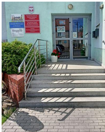
Zdjęcie przedstawiające wejście do budynku przy ul. Wrocławskiej 8
